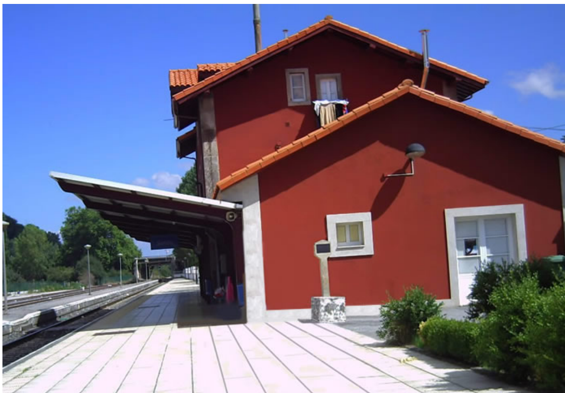
Pequeña estación de FFCC.
